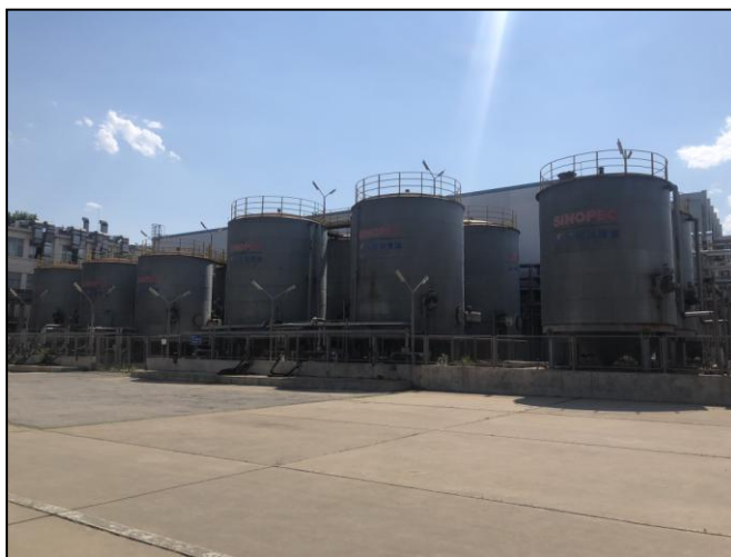
照片 11 原添加剂罐区
