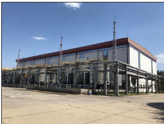
照片5 原特油罐区
