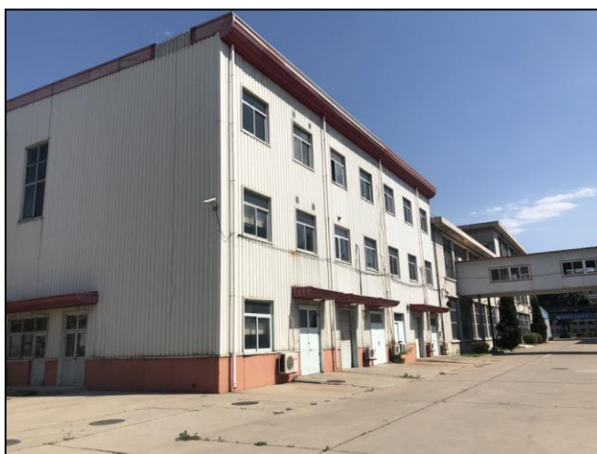
照片 3 原 OCP 厂房
