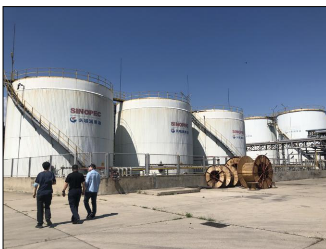
照片 4 原基础油罐区
