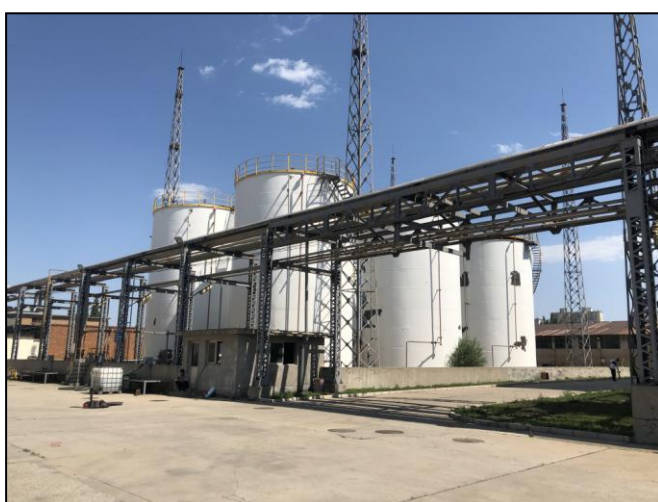
照片7 乙二醇罐区
